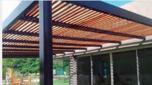
**Fusion Pergolas**, sólidas columnas y tirantes en madera compuesta para construir espacios semi cubiertos.
